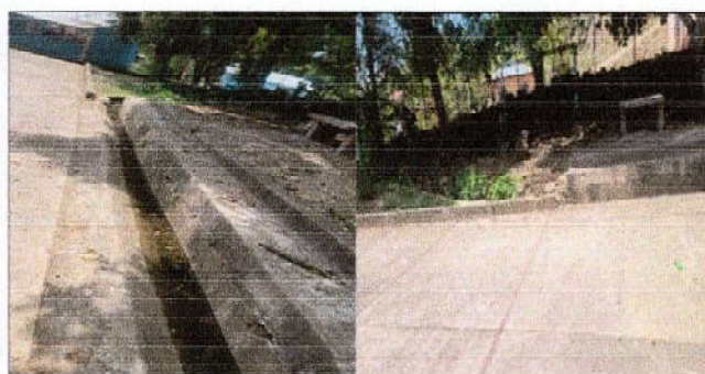
Reparacion de banquetas de concreto
