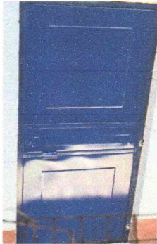
Foto No. 7: PUERTA NUEVA
