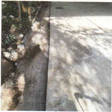
Foto No. 2: PISO DE CONCRETO CON SU CANAL DE AGUA
