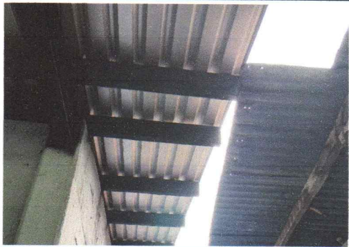
Foto 5: ESTRUCTURA DE SOPORTE LIJADO Y PINTADO
