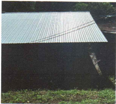
Foto No. 4: TECHO DE BODEGA FINALIZADO
