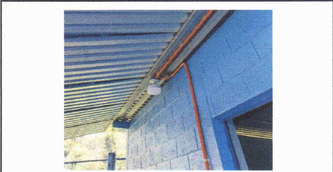
Foto 8: sustitución de cable eléctrico
