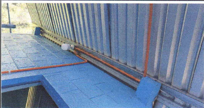
Foto 2: sustitución de estructura de madera, por metal
