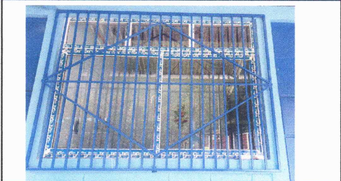
Foto 9: Sustitución de balcones
