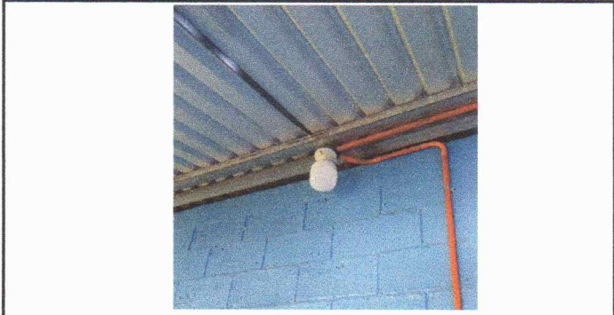
Foto 7: sustitución de plafonera
