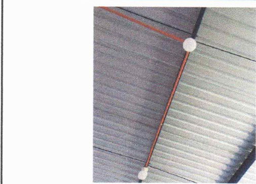
Foto 1: Sustitución de lámina troquelada aluzinc calibre 26
