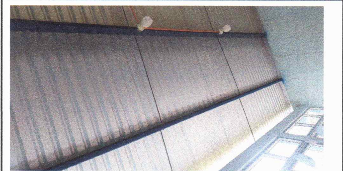
Foto 11: manenimiento de costaneras
