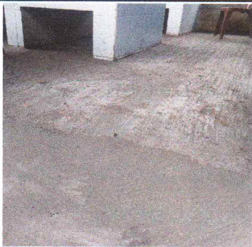
Foto 3: sustitución de piso de torta de concreto
