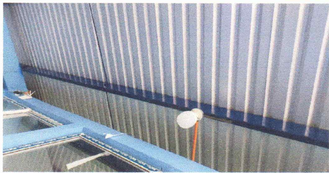
Foto 4: sustitución de bombillos Led
