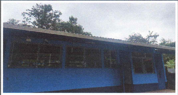
Foto 10: sustitución de canal con sus accesorios
