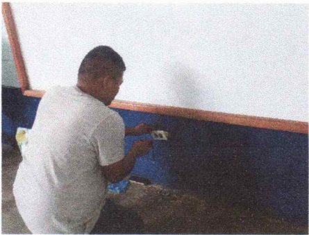
Foto 5: sustitución de tomacorrientes doble
