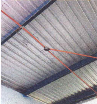
Foto 4: sustitución de bombillos Led
