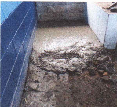
Foto 3: sustitución de piso de torta de concreto
