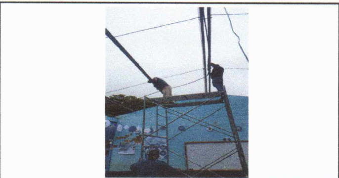
Foto 11: manenimiento de costaneras
