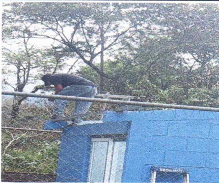
Foto 2: sustitución de estructura de madera, por metal
