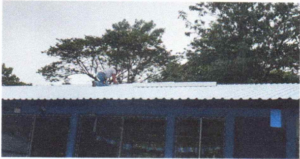
Foto 1: Sustitución de lámina troquelada aluzinc calibre 26
