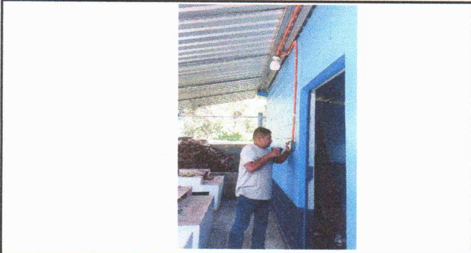
Foto 7: sustitución de plafonera
