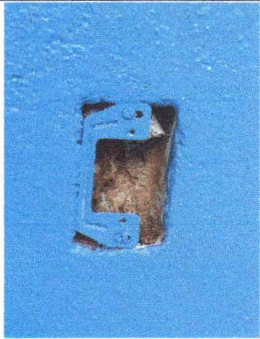
Foto 6: sustitución de apagadores sencillos
