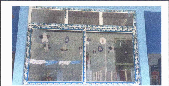
Foto 9: Sustitución de balcones
