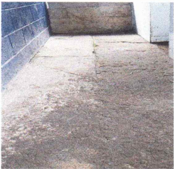
Foto 3: sustitución de piso de torta de concreto
