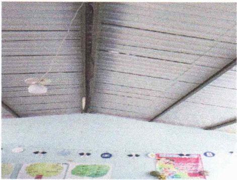
Foto 1: Sustitución de lámina troquelada aluzinc calibre 26
