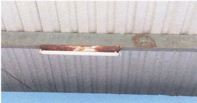
Foto 4: sustitución de bombillos Led
