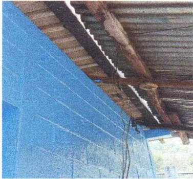
Foto 2: sustitución de estructura de madera, por metal
