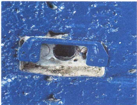
Foto 5: sustitución de tomacorrientes doble
