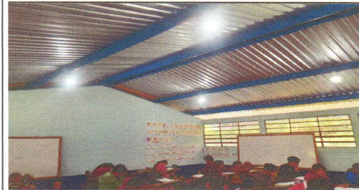
Foto 9: Cambio de ductos eléctricos, plafoneras y focos.
