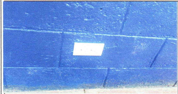
Foto 7: instalación de cableado y tomacorrientes.
