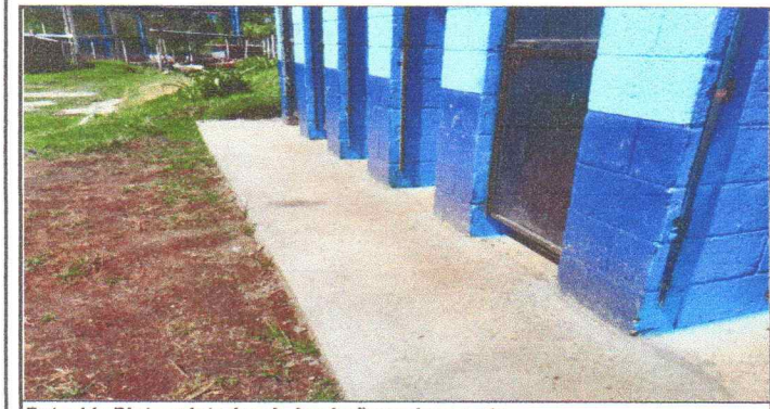
Foto 11: Pintura interior de los baños y banqueta.
