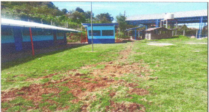
Foto 10: Red de drenaje instalada completamente.
