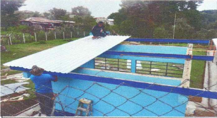
Foto1: Instalación de láminas.
