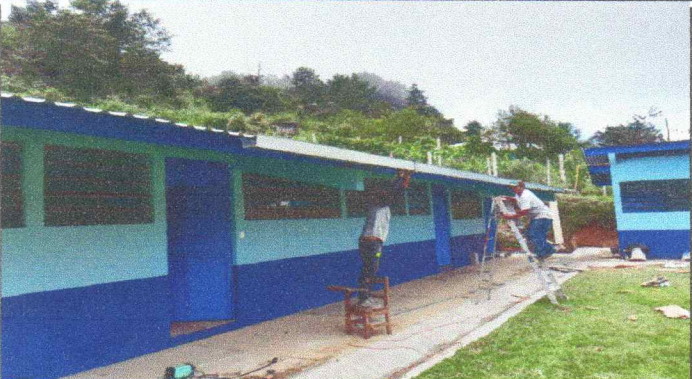
Foto 2: Instalación de canales y bajadas de agua.
