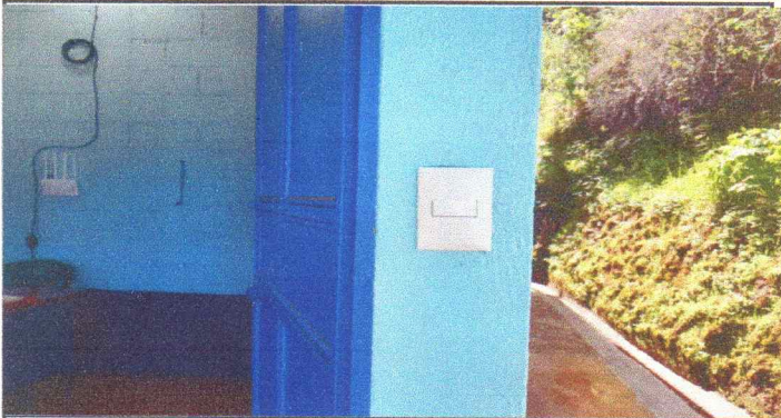
Foto 8: instalación de interruptores.
