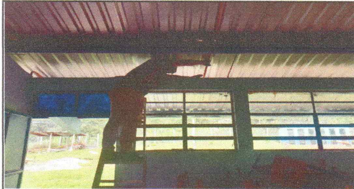
Foto 9: Cambio de ductos eléctricos.
