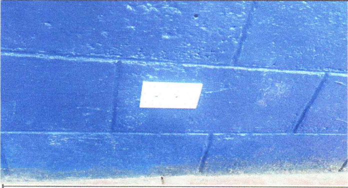
Foto 7: instalación de cableado y tomacorrientes.
