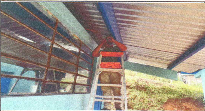
Foto 4: trabajo en instalación eléctrica.
