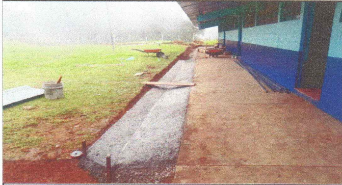
Foto 3: Trabajo en cunetas de concreto
