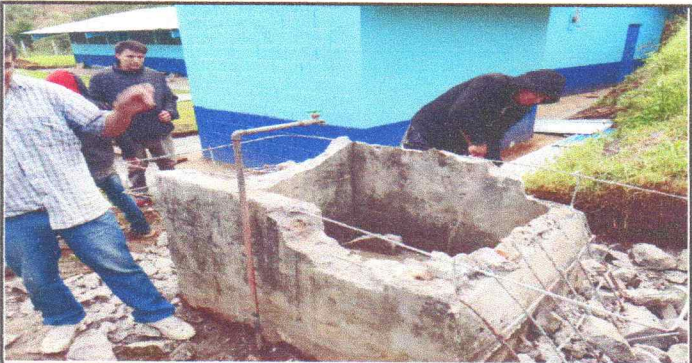
Foto 6: Reparación de pila de concreto.
