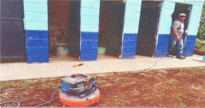
Foto 11: Pintura interior de los baños y banqueta.
