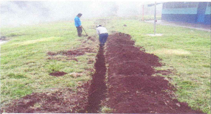
Foto 10: Reparación de red de drenaje.
