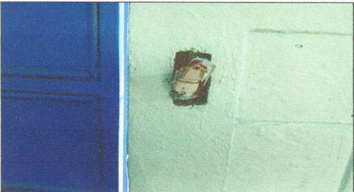
Foto 8: interruptores deteriorados.
