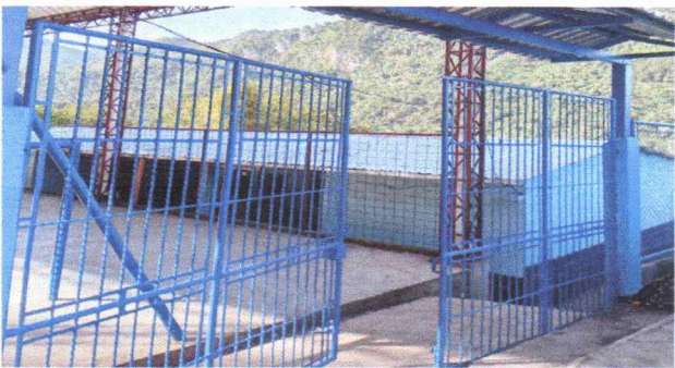
Foto 3: Reparación de portón de metal
