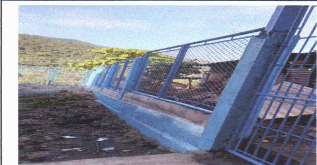
Foto 11: Fabricación e instalación de tubería galvanizada con malla tensada
