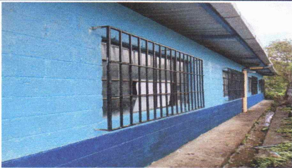
Foto 6: Pintura en muros exteriores e interiores
