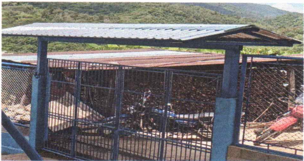
Foto 1: Sustrucción de lámina troquelada por lámina Azulic calibre 26
