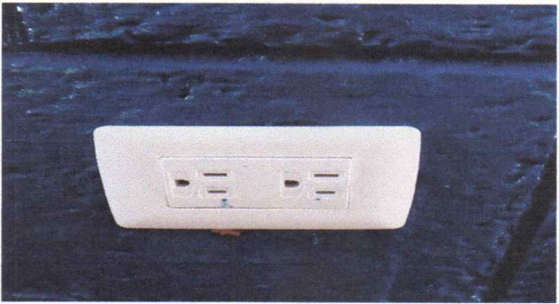
Foto 10: Sustitución de interruptores
