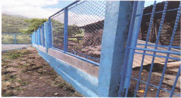
Foto 8: Reparación de tubo HG y malla galvanizada
