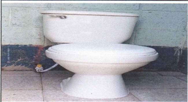
Foto 7: Sustitución de inodoro
