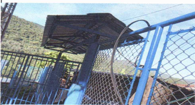
Foto 2: Estructura de techo
