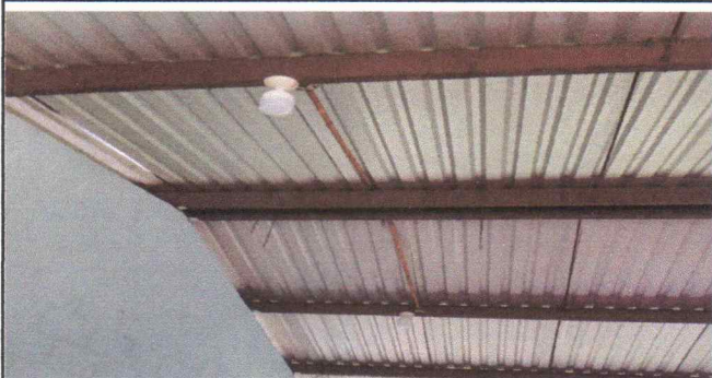
Foto 9: Sustitución de lámparas de tubo
