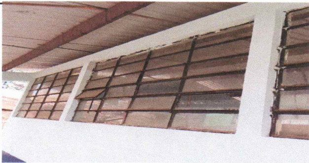
Foto 4: Sustrucción de vidrios
