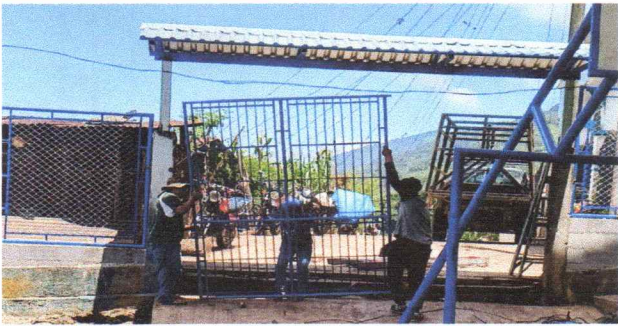
Foto 3: Mantenimiento de porton
