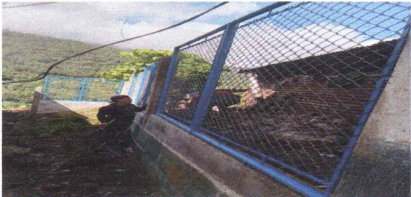
Foto 11: Fabricación e instalación de tubería galvanizada con malla tenzada
