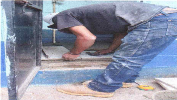
Foto 7: Sustitución de inodoro
