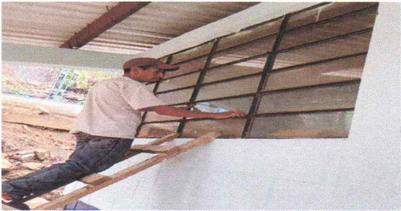
Foto 4: Sustitución de vidrios
