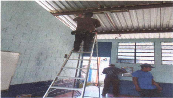
Foto 9:Sustitución de lámparas de tubo
