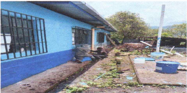
Foto 6: Pintura en muros interiores e exteriores
