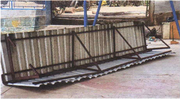
Foto 1: Sustitución de lámina troquelada por lámina Azulic calibre 26
