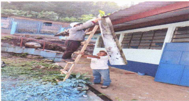
Foto 5: Sustitución de bajada de agua pluvial de metal por tubo PVC 3"
