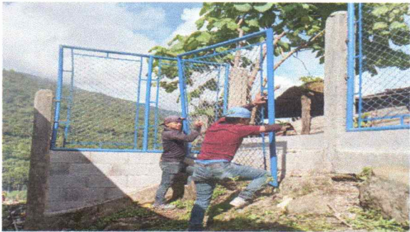
Foto 8: Reparación de tubo y malla galvanizada
