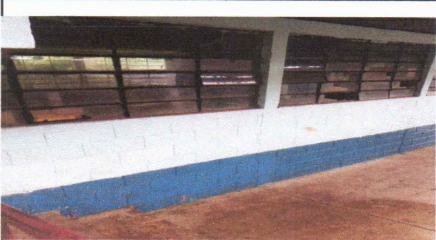
Foto 4: Sustrucción de vidrios
