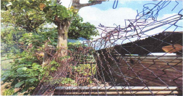
Foto 8: Reparación de tubo y malla galvanizada
