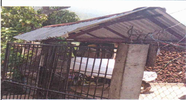
Foto 1: Sustrucción de lámina troquelada por lámina Azulic calibre 26
