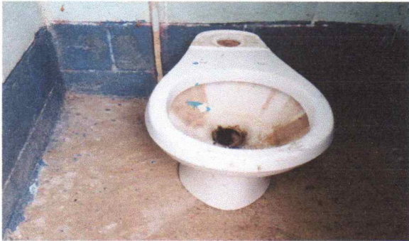
Foto 7: Sustitución de inodoro
