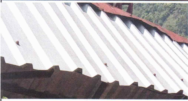
Foto 2: Estructura de techo
