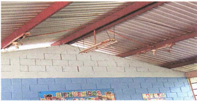
Foto 9: Sustitución de lámparas de tubo
