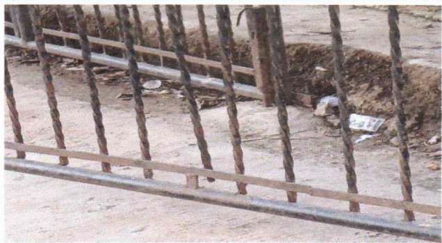
Foto 3: Mantenimiento a porton de metal de ancho 420 cm por 220 cm de alto
