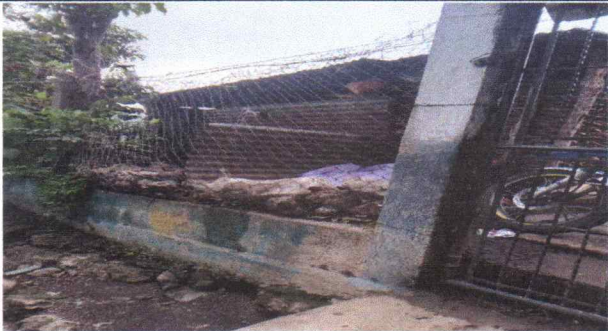
Foto11: Fabricación e instalación de tubería galvanizada con malla tensada
