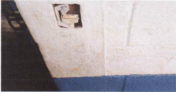
Foto 10:Sustitución de interruptores
