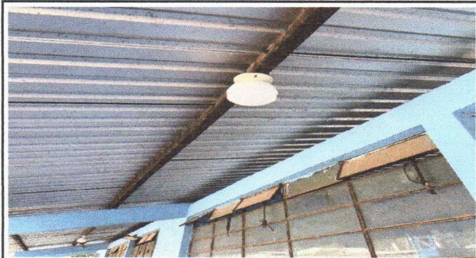
Foto 3: Reparacion de cableado electrico, sustitución de plafoneras,interruptores,tomacorrientes, sustitución de tablero de flípones.
