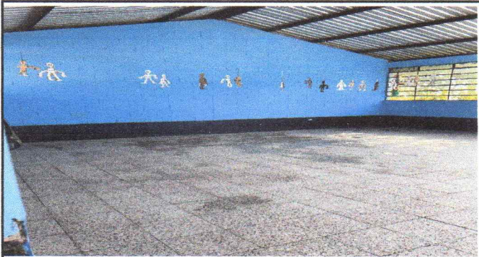
Foto1: Sustitución de piso
