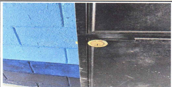
Foto 6:Sustitución de chapa
