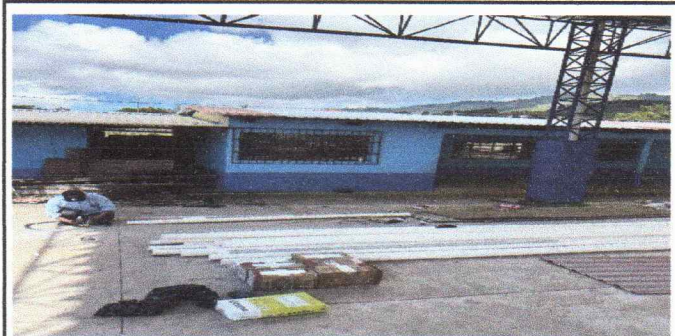
Foto 5: Sustitución de canales por caída de agua pluvial
