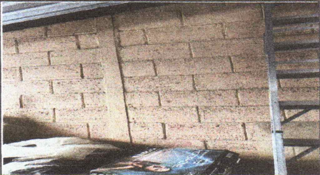
Foto 2: Pintura a interiores
