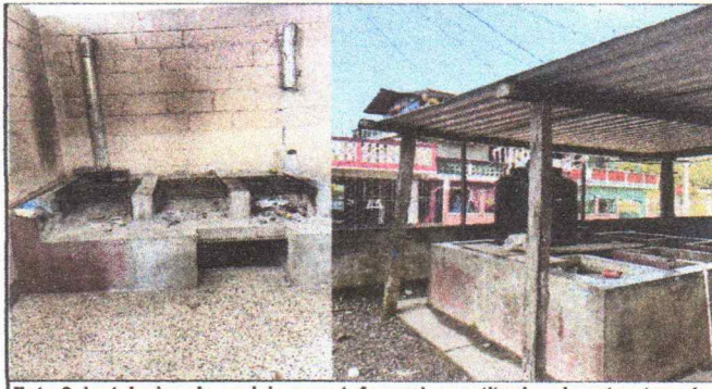
Foto 6: Instalacion de azulejo en estufa rural y sustitucion de estructura de soporte de madera por metal.
