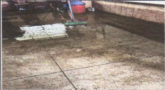
Foto1: Cambio de piso de torta de cemento por piso de granito
