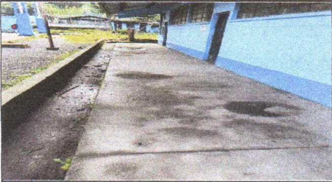
Foto 4: Cambio de piso de torta de cemento por piso de granito
