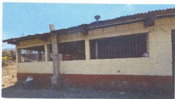
Foto 3: Sustitución de estructura de metal de ventana
