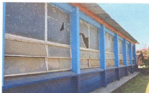
Foto 4: Sustitución de ventana por estructura de metal y vidrio
