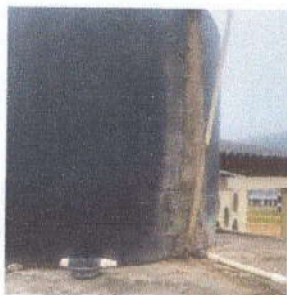
Foto 5: Sustitución de depósito de agua en baño.
