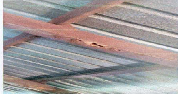
Foto 2: SUSTITUCIÓN TECHO DE MADERA MODULO 1 EDIFICIO WELTIX
