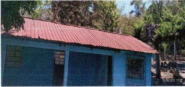
Foto1: SUSTITUCIÓN LAMINA DE METAL, MODULO 1 EDIFICIO WELTIX
