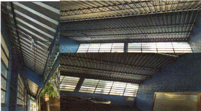
Foto 3: Sustitución de elementos de fijación
