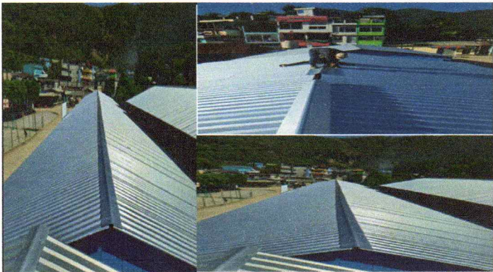
Foto 4: Mantenimineto a estructura de soporte de metal
