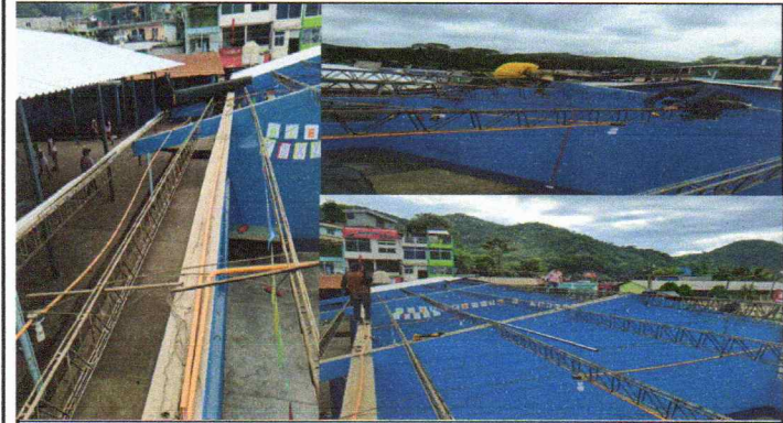
Foto 3: Sustitución de elementos de fijación
