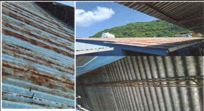
Foto 3: Sustitución de elementos de fijación
