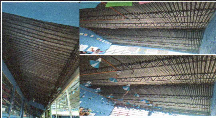
Foto 4: Mantenimineto a estructura de soporte de metal
