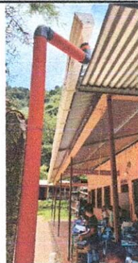
Foto 2: Lámina nueva, colocación nueva de soporte de metal, canal pluvial y bajada de agua.
