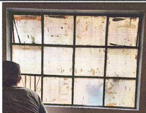
Foto 6: Retiro de ventana.
