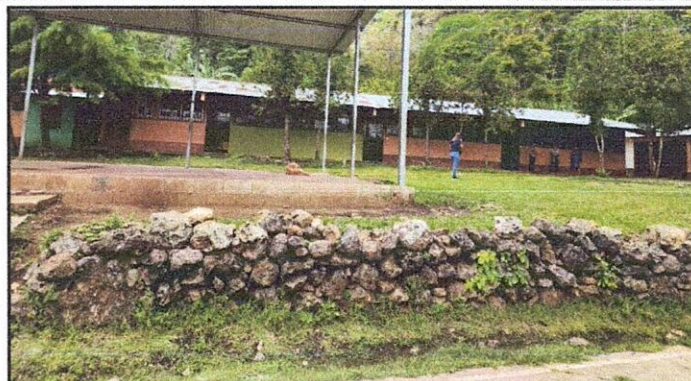
Foto 2: Lámina en malas condiciones.
