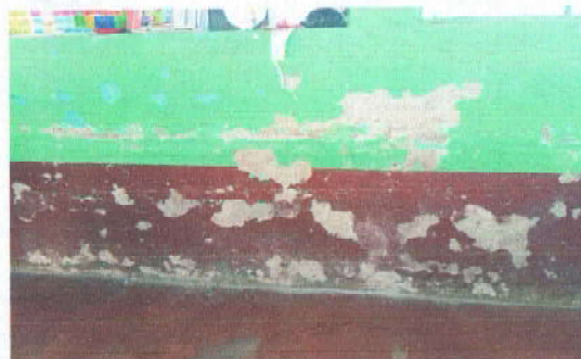
Foto 6: Repello de paredes
