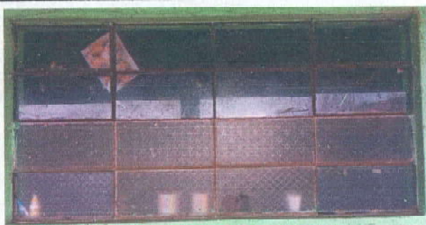
Foto 5: Sustrucción de ventana de metal + vidrio por ventana de PVC + vidrio
