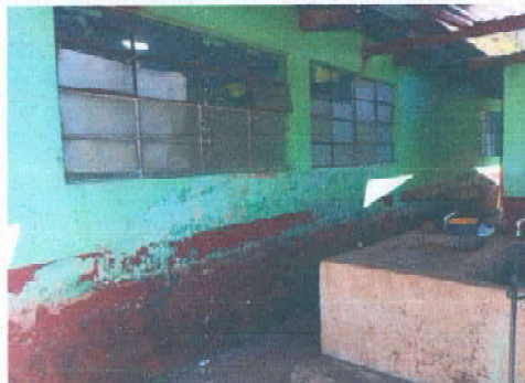
Foto 2: Pintura a muros exteriores e interiores
