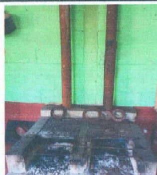
Foto 4: Reparación a estufa rural con chimenea
