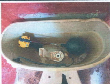
Foto 3: Sustrucción de accesorios de baños (fiote, empaque, palanca, tubo de abasto)
