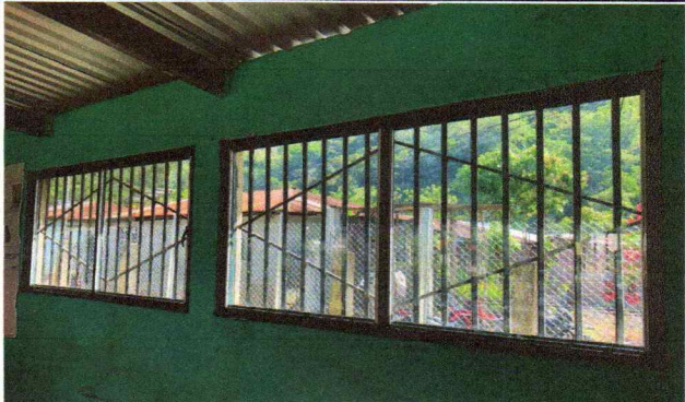
Foto 2: Mejoramiento de estructura de metal de ventana de 2.00 mts. de largo por 1.00 mt. de ancho.
