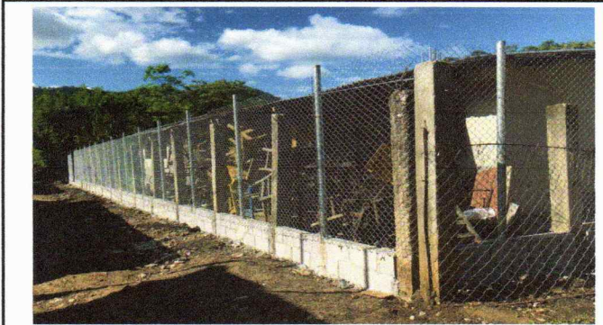
Foto 5: Reparación de tubo HG y malla galvanizada
