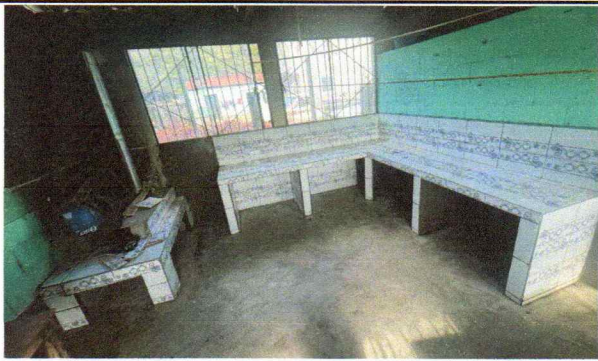
Foto 6: Mejoramiento de mesa de concreto en cocina
