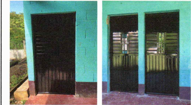
Foto1: Sustitución de puerta 2.10 mts. de alto por 1.00 mt. De ancho
