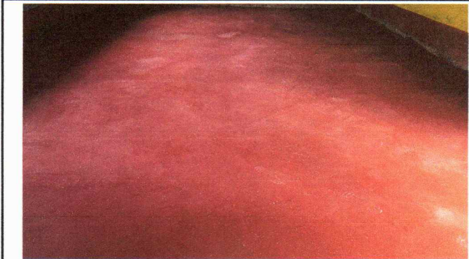
Foto 3: Sustitución de piso de cemento líquido
