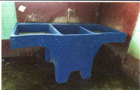
Foto 4: Sustitución de pila de concteto con dos lavaderos
