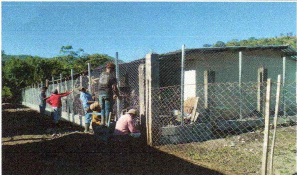
Foto 5: Reparación de tubo HG y malla galvanizada
