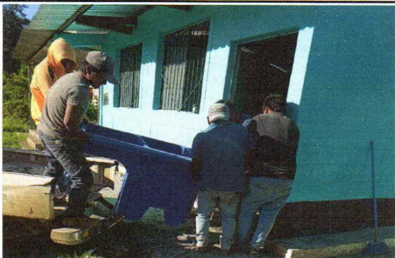
Foto 4: Sustitución de pila de concreto con dos lavaderos
