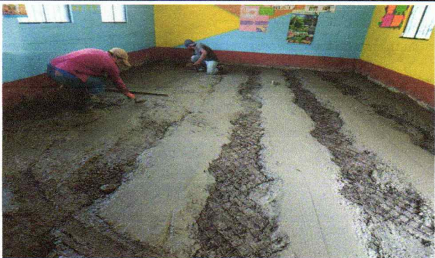
Foto 3: Sustitución de piso de cemento líquido
