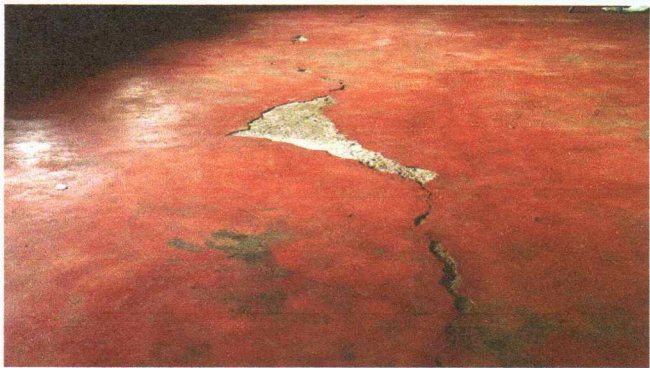
Foto 3: Sustitución de piso de cemento líquido
