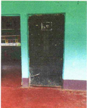
Foto1: Sustitución de puerta 2.10 mts. de alto por 1.00 mt. De ancho
