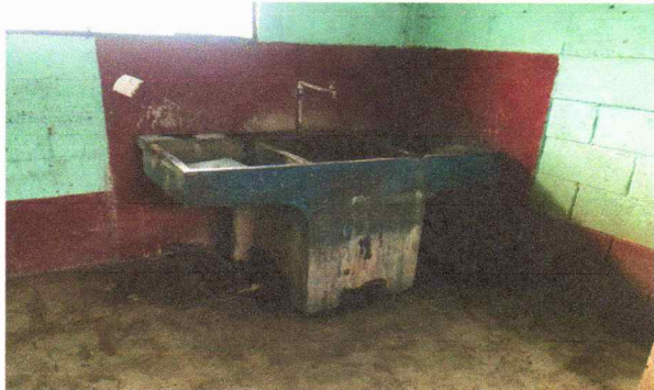
Foto 4: Sustitución de pila de concteto con dos lavaderos
