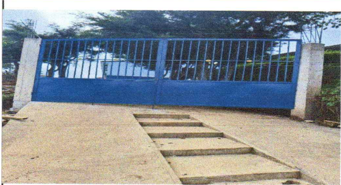
Foto1: Sustitución de portón de metal por metal.
