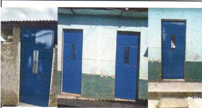
Foto 2: Sustitución de puerta de madera por puerta de metal
