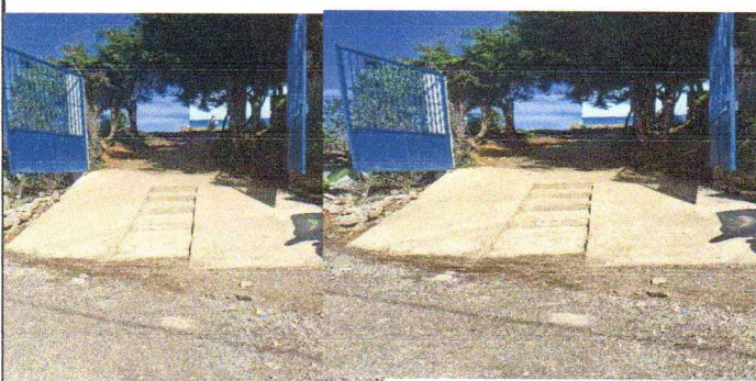
Foto 4. Sustitución de piso de torta de concreto
