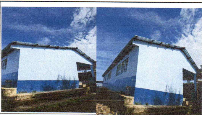
Foto 3. sustitución de lámina por lámina troquelada
