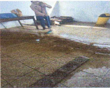
Foto 4. Sustitución de piso de torta de concreto por piso de granito
