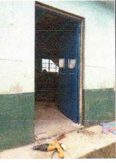
Foto 2: Sustitución de puerta de madera por puerta de metal
