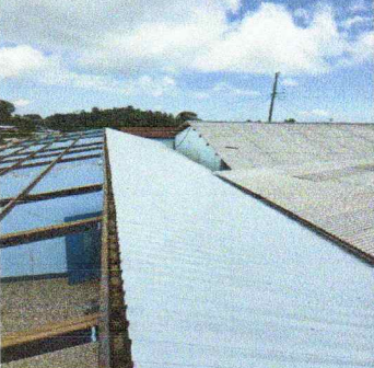
Foto 3. sustitución de lámina por lámina troquelada
