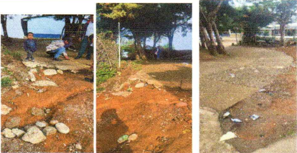
Foto 4. Sustitución de piso de torta de concreto
