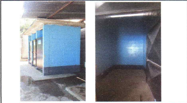
Foto 7: Pintura en muros exteriores e interiores.
