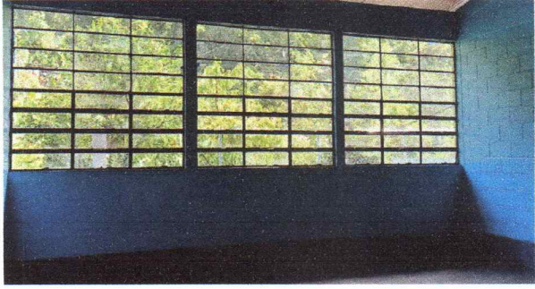
Foto 2: Sustitución de vidrios.
