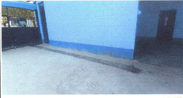
Foto 6: Reparación de cuneta de concreto.
