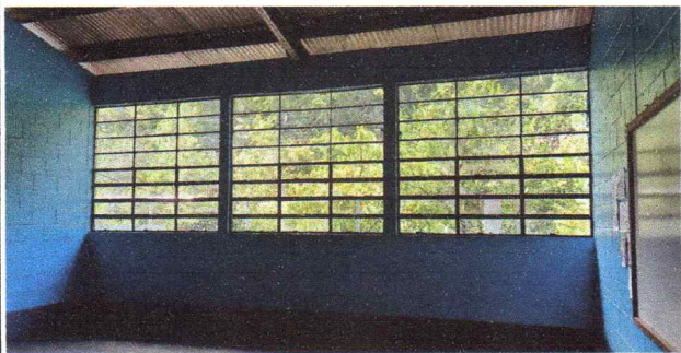
Foto1: Mantenimiento a estructura de metal de ventana.
