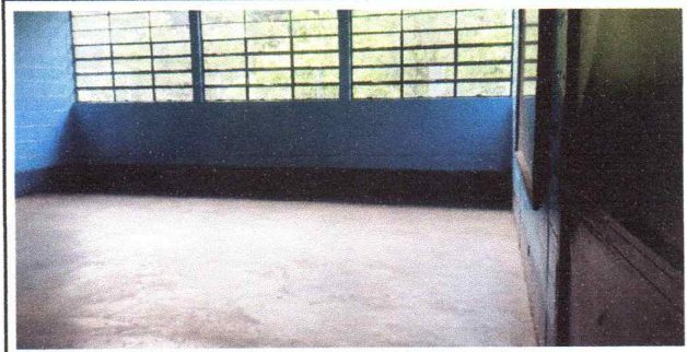
Foto 5: Sustitución de piso de cemento líquido.
