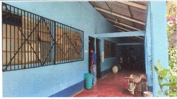
Foto 4: Mejoramiento de balcones.
