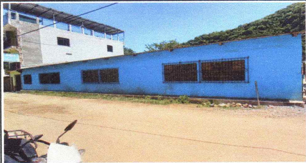
Foto 3: Mantenimiento a balcones de estructura metálica.
