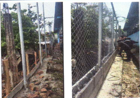
Foto 9: Reparación de tubo hg y malla galvanizado.
