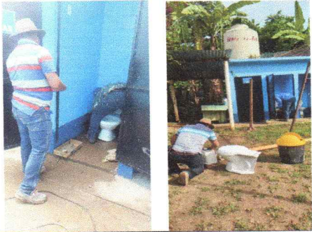
Foto 8: Sustitución de inodoro.
