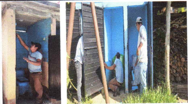
Foto 7: Pintura en muros exteriores e interiores.
