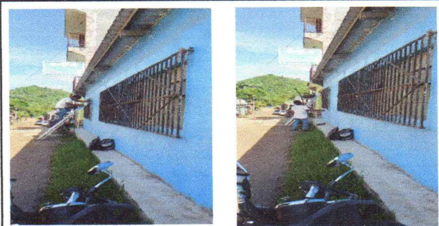
Foto 3: Mantenimiento a balcones de estructura metálica.
