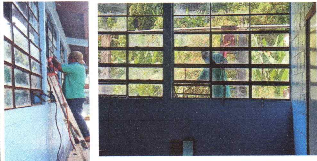
Foto 1: Mantenimiento a estructura de metal de ventana.
