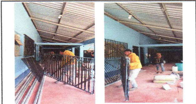
Foto 4: Mejoramiento de balcones.
