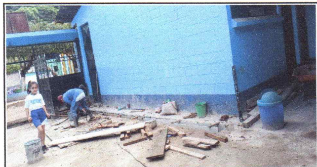
Foto 6: Reparación de cuneta de concreto.
