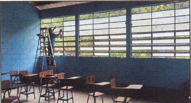
Foto 2: Sustitución de vidrios.
