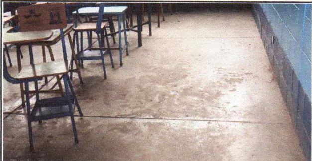
Foto 5: Sustitución de piso de cemento líquido.
