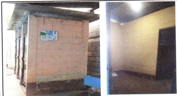
Foto 7: Pintura en muros exteriores e interiores.
