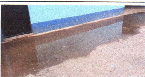
Foto 6: Reparación de cuneta de concreto.
