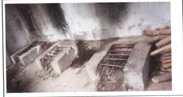
Foto 10: Mantenimiento a estufa rural y sustitución de estufa rural completa.
