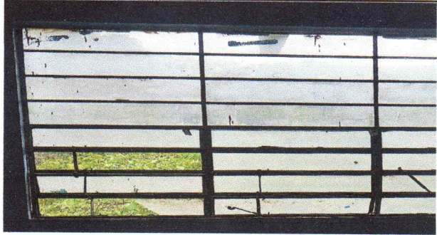
Foto1: Mantenimiento a estructura de metal de ventana.
