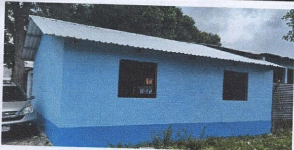
Foto1: cambio de techo de cocina
