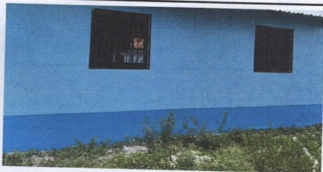
Foto 5: Pintura en muro perimetral
