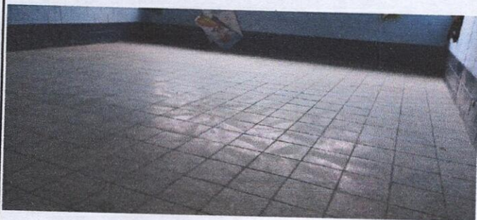
Foto 3: Sustitución de piso de torta cemento a piso de granito
