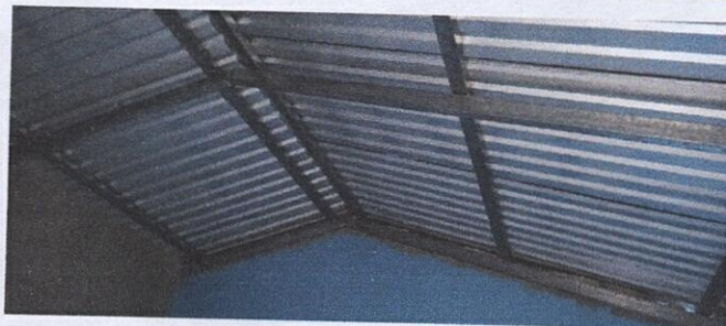
Foto 2: Sustitución de soporte de madera por metal
