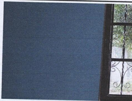
Foto 6: repello en muro
