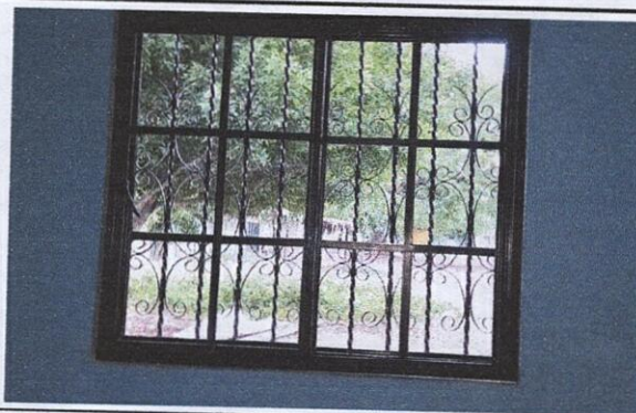
Foto 4: Sustitución de estructura de metal de ventana más vidrio
