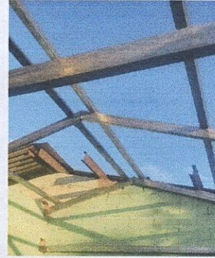
Foto 2: Sustitución de soporte de madera por metal
