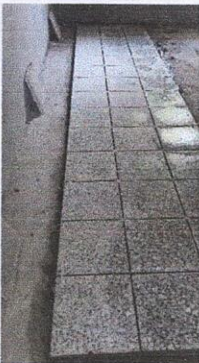
Foto 3: Sustitución de piso de torta cemento a piso de granito
