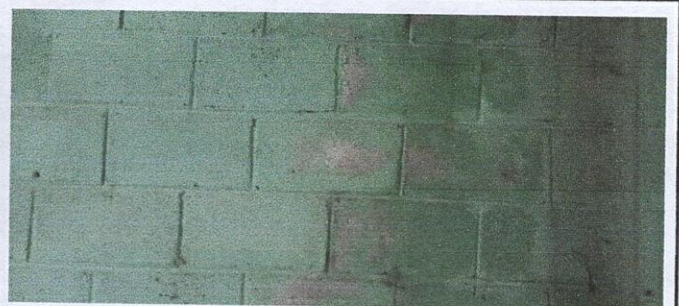
Foto 5: Pintura en muro perimetral
