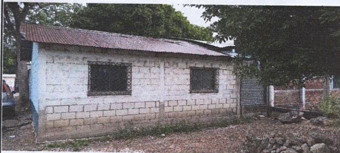
Foto1: cambio de techo de cocina
