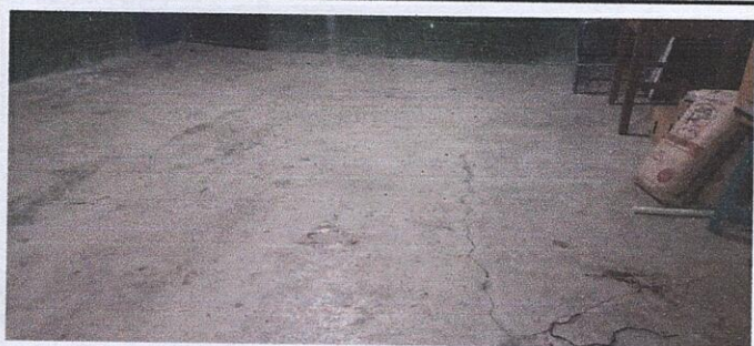
Foto 3: Sustitución de piso de torta cemento a piso cerámico
