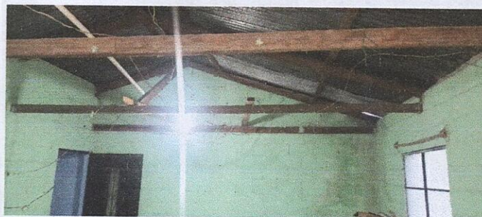
Foto 2: Sustitución de soporte de madera ppor metal
