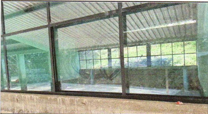
Foto 3: SUSTITUCION DE VENTANAS
