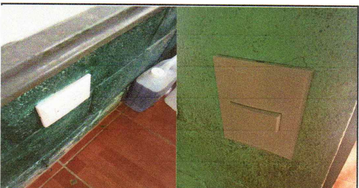
Foto 6: SUSTITUCIÓN DE TOMACORRIENTES E INTERRUPTORES
