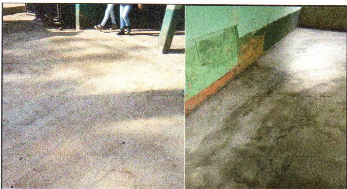
Foto 4: SUSTITUCIÓN DE PISO DE TORTA DE CEMENTO
