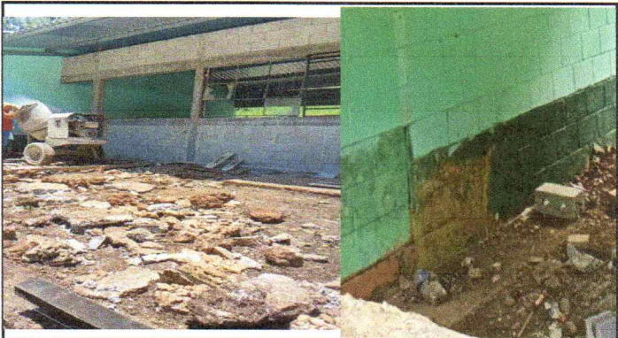
Foto 4: SUSTITUCIÓN DE PISO DE TORTA DE CEMENTO
