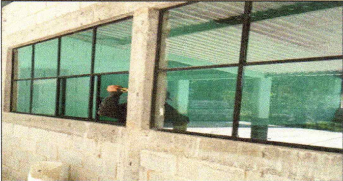
Foto 3: SUSTITUCION DE VENTANAS
