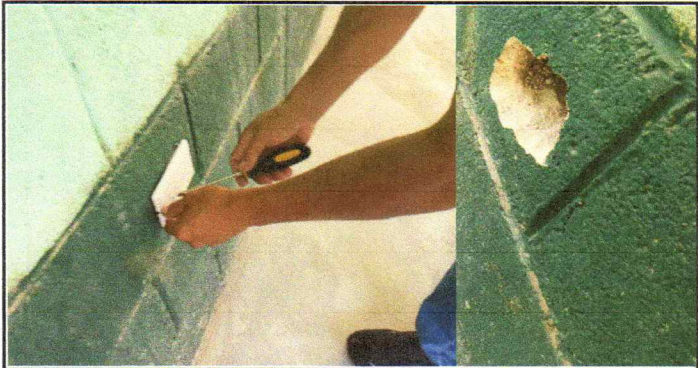
Foto 6: SUSTITUCIÓN DE TOMACORRIENTES E INTERRUPTORES
