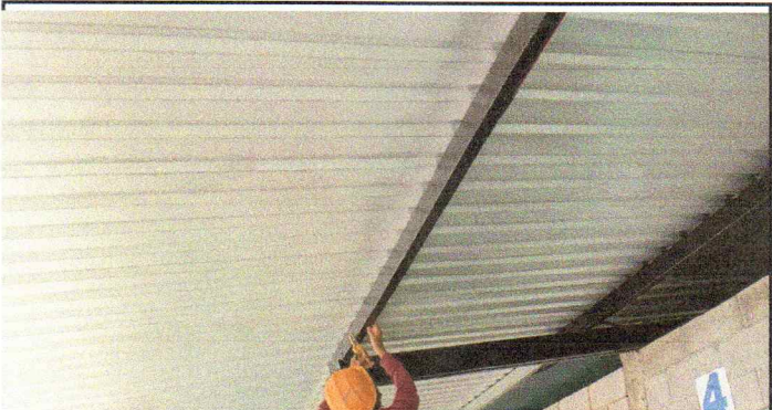
Foto 2: SUSTITUCIÓN DE ESTRUCTURA DE TECHO
