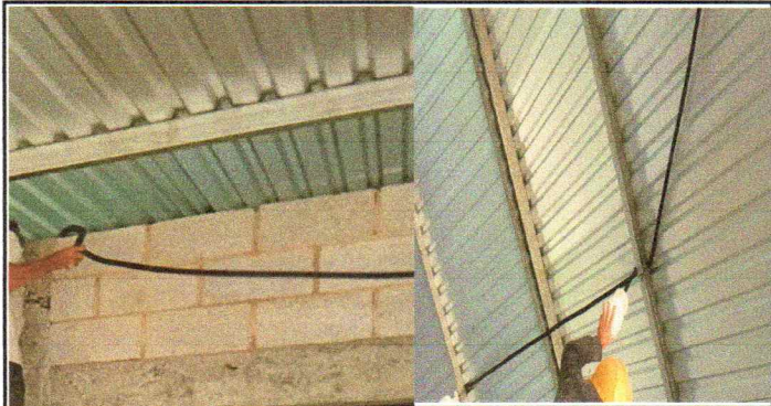
Foto 5: REPARACION DE TENDIDO ELÉCTRICO, PLAFONERAS Y FOCOS AHORRADORES
