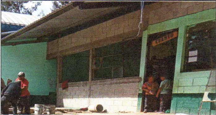
Foto1: CUBIERTA DE LÁMINA:
