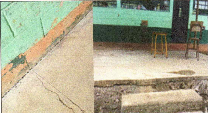
Foto 4: SUSTITUCIÓN DE PISO DE TORTA DE CEMENTO
