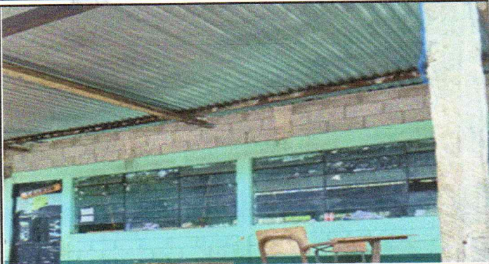
Foto1: CUBIERTA DE LÁMINA:
