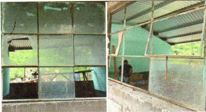
Foto 3: SUSTITUCION DE VENTANAS
