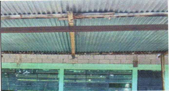
Foto 2: SUSTITUCIÓN DE ESTRUCTURA DE TECHO
