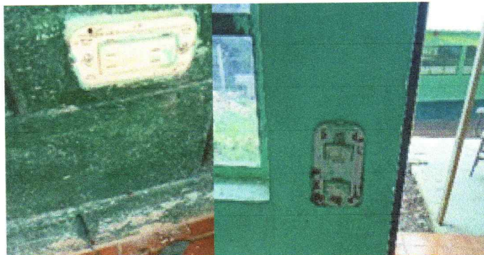
Foto 6: SUSTITUCIÓN DE TOMACORRIENTES E INTERRUPTORES
