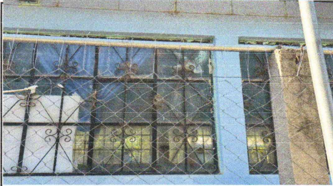
Foto1: Mejoramiento de muro perimetral consistente en colocacion de tubos galvanizados para sujetar la malla.
