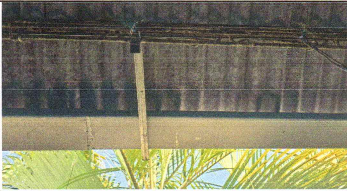
Foto 3: Situación actual del soporte para canales de agua pluvial.
