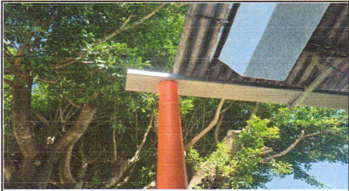
Foto 4: Situación actual de la instalacion de bajada de agua pluvial.
