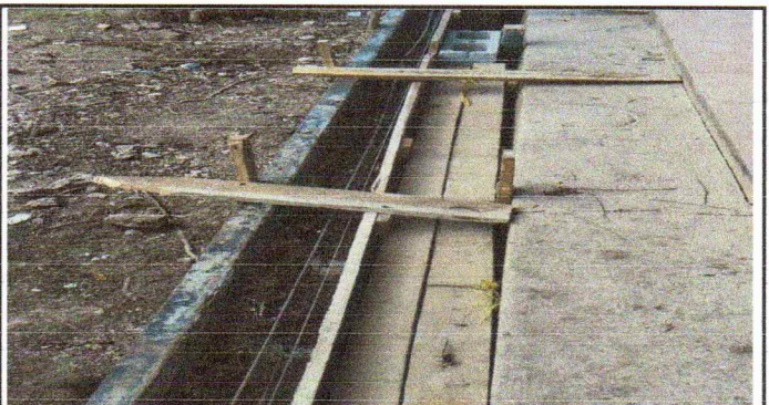
Foto 6: Situación de la cunetas de agua pluvial de la escuela.
