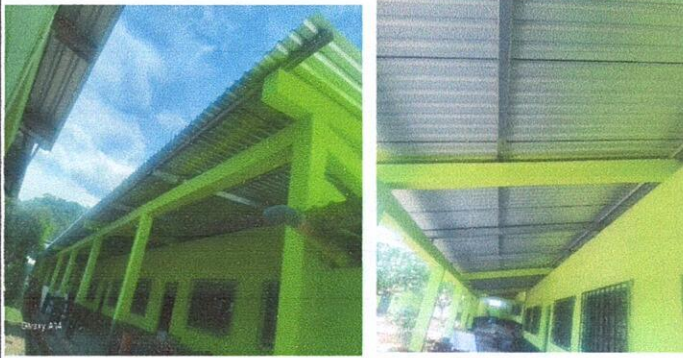
Foto1: CUBIERTA DE LAMINA
