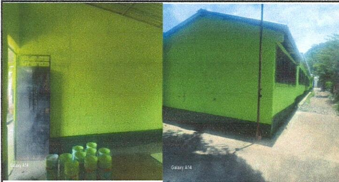
Foto 3: PINTURA INETRIOR Y EXTERIOR
