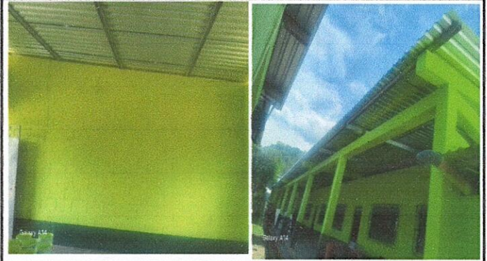
Foto 2: ESTRUCTURA DE TECHO
