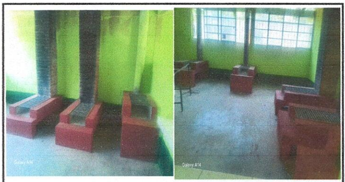
Foto 6: MANTENIMIENTO DE ESTUFA RURAL Y SUSTITUCION DE PLANCHA POR PARILLA
