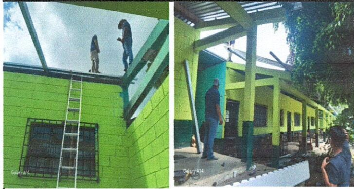
Foto1: CUBIERTA DE LAMINA
