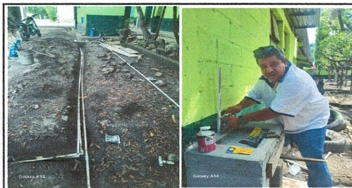
Foto 5: REPARACION DE RED DE AGUA POTABLE
