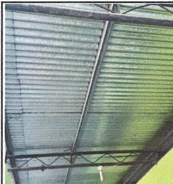
Foto1: CUBIERTA DE LAMINA
