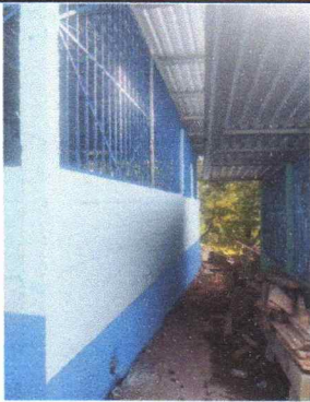
Foto 8: Sustitución de malla por balcones de metal
