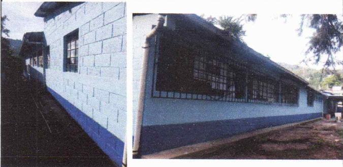
Foto : ANEXO 4: otras áreas de pintura en exteriores
