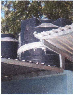
Foto 12: Sustitución de deposito de agua
