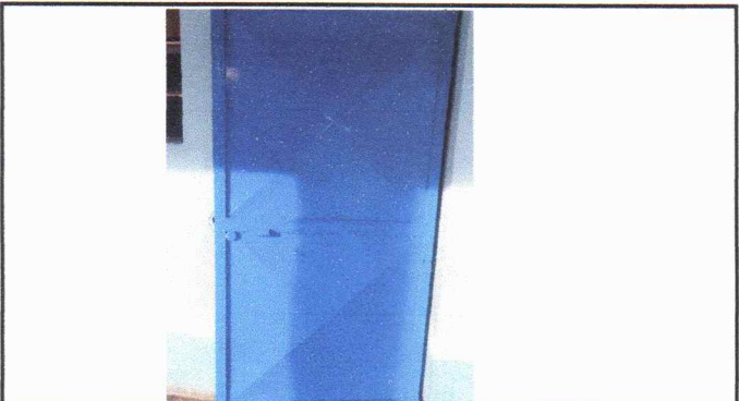
Foto 4: Sustrucción de Chapas
