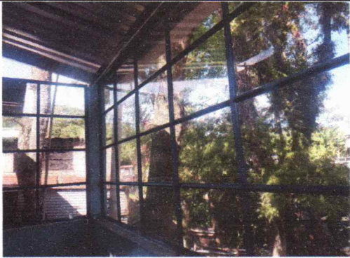
Foto7: Sustitución de estructura de metal de ventana
