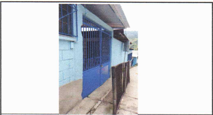
Foto 6: Sustrucción de portón de metal
