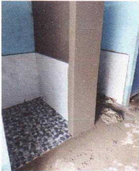
Foto : ANEXO 3: Mejoramiento con azulejo en sanitarios
