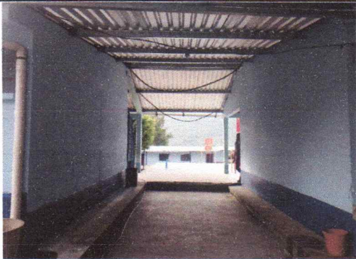
Foto 10: Pintura en muros exteriores e interiores
