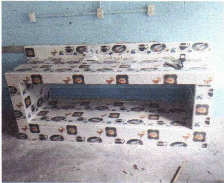
Foto13: Mejoramiento de mesa de concreto en cocina
