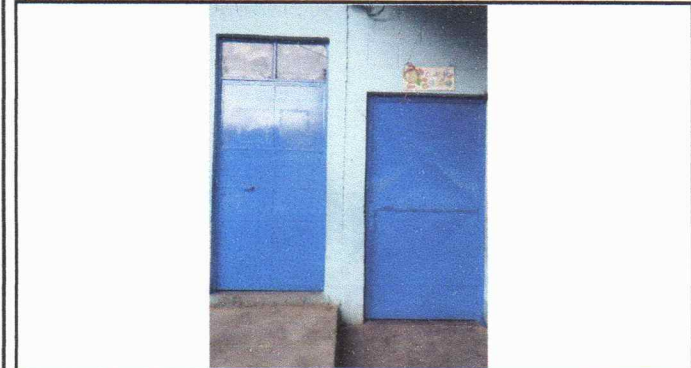
Foto 3: Mantenimiento a estructura de puertas de metal
