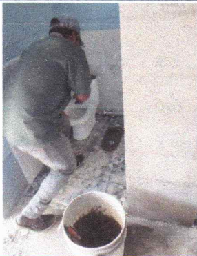
Foto 11: Sustrucción inodoro y Mejoramiento de azulejo en servicios sanitarios
