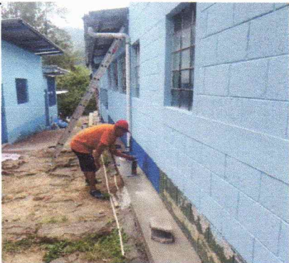
Foto 10: Pintura en muros exteriores e interiores
