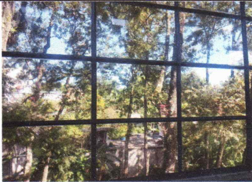
Foto7: Sustrucción de estructura de metal de ventana
