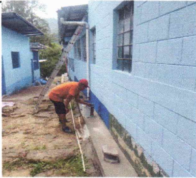
Foto 10: Pintura en muros exteriores e interiores
