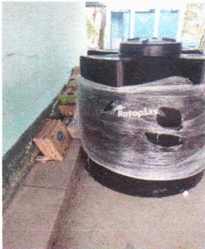
Foto 12: Sustrucción de deposito de agua
