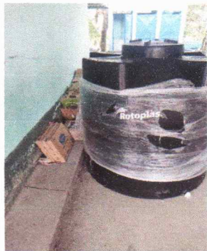
Foto 12: Sustrucción de depósito de agua
