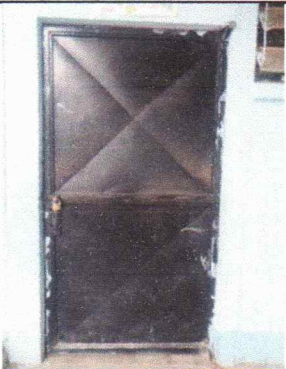
Foto 3: Mantenimiento a estructura de puertas de metal
