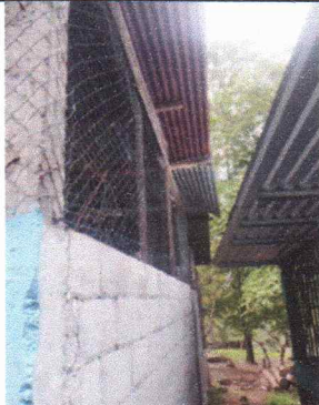
Foto 8: Sustitución de malla por balcones de metal
