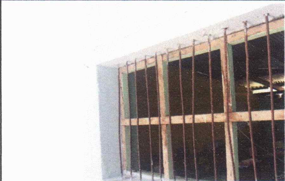
Foto7: Sustitución de estructura de metal de ventana
