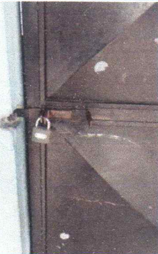
Foto 4: Sustrucción de Chapas
