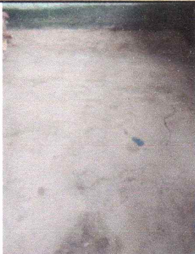
Foto 9: Sustitución de piso de torta de concreto
