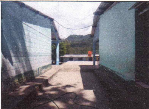
Foto 10: Pintura en muros exteriores e interiores
