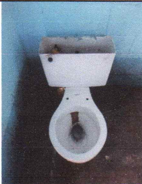
Foto 11: Sustitución inodoro y Mejoramiento de azulejo en servicios sanitarios
