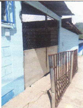
Foto 6: Sustrucción de portón de metal
