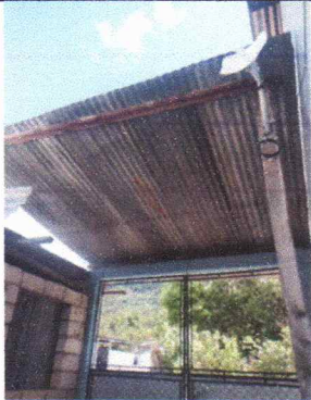
Foto1: Sustrucción de lámina, por lámina troquelada
