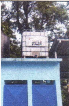
Foto 12: Sustitución de deposito de agua
