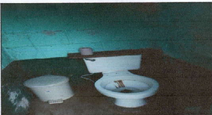
Foto 3: Sustrucion de inodoro No 03 en el establecimiento
