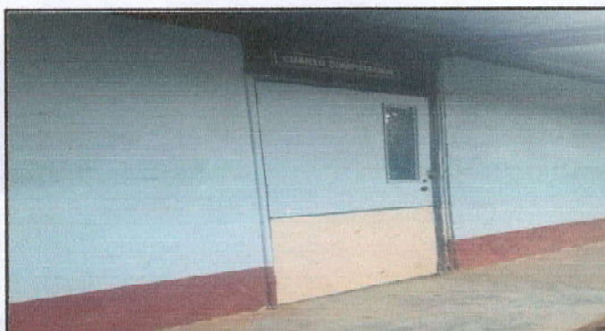
Foto 3: Sustritución de puerta en un aula.
