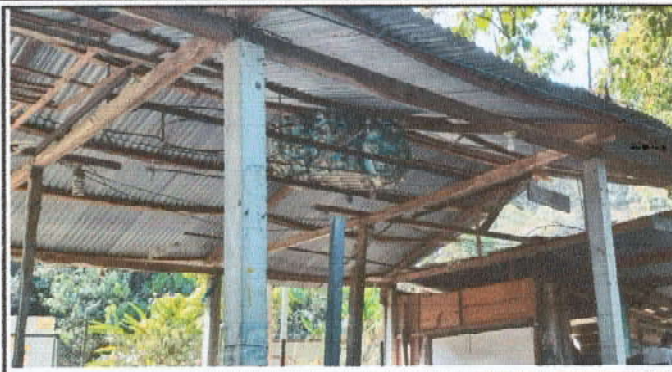
Foto 2: Sustrución de techo de lamina en el taller de mecánica automotriz.
