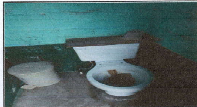
Foto 4: Sustrucion de inodoro No. 04 en el establecimiento
