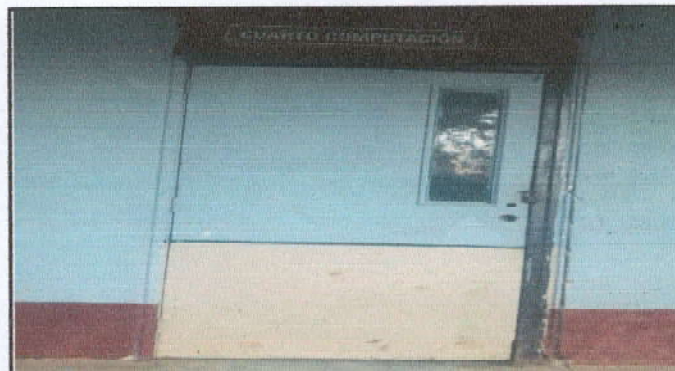
Foto 4: Sustritución de puerta en un aula.
