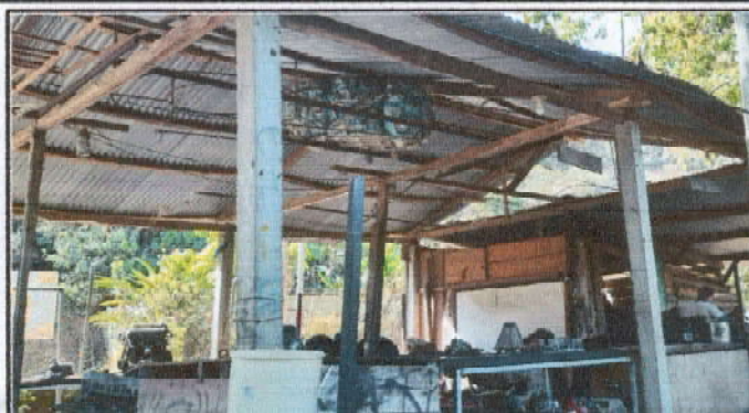
Foto 1: Mejoramiento de Circulación con maya en el taller de mecánica automotriz
