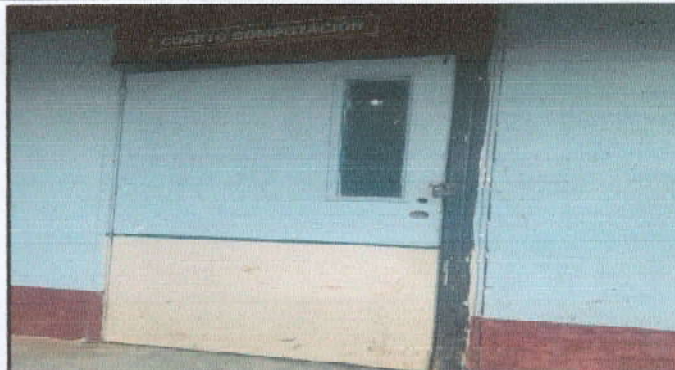
Foto 2: Sustritución de puerta en un aula.
