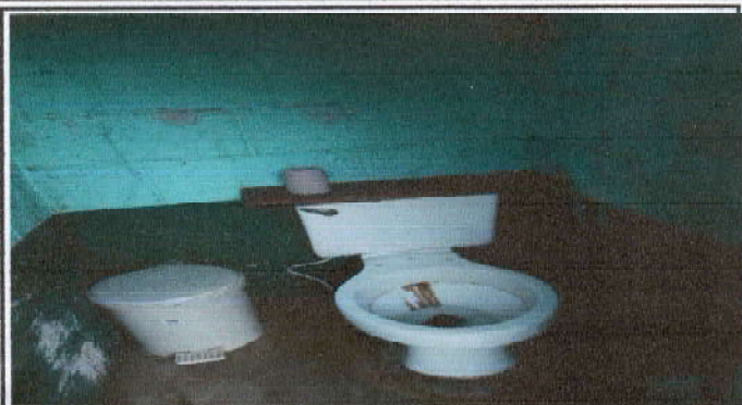
Foto1: Sustrucion de inodoro No. 01 en el establecimiento
