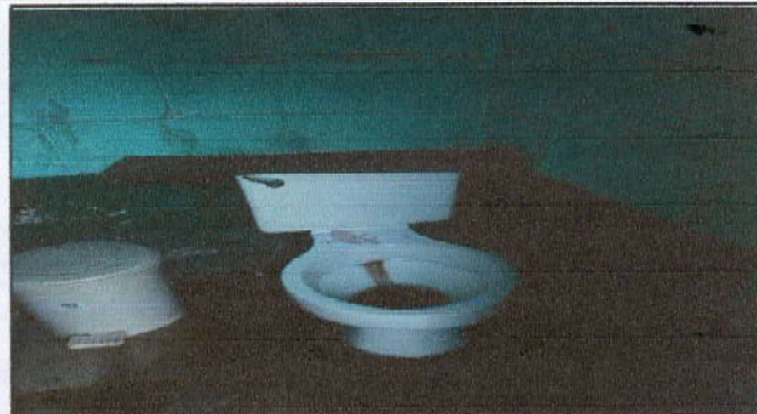
Foto 2: Sustrucion de inodoro No 02 en el establecimiento
