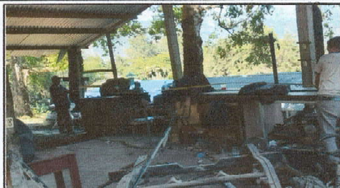
Foto 2: Mejoramiento de Circulación con maya en el taller de mecánica automotriz
