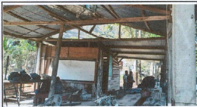
Foto 3: Sustrución de techo de lamina en el taller de mecánica automotriz.
