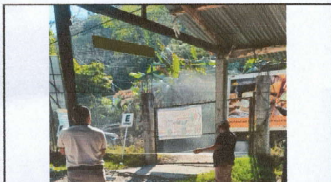
Foto 3: Mejoramiento de Circulación con maya en el taller de mecánica automotriz
