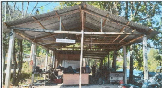
Foto1: Sustrución de techo de lamina en el taller de mecánica automotriz.
