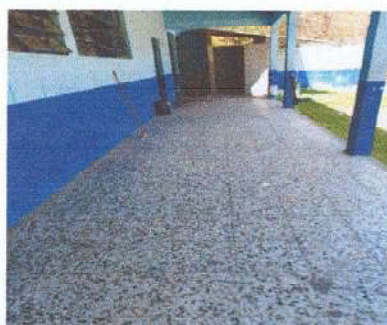
Foto 12: Pintura en muros de exteriores e interiores
