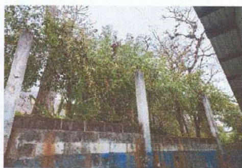
Foto 11: Pintura en muros de exteriores e interiores
