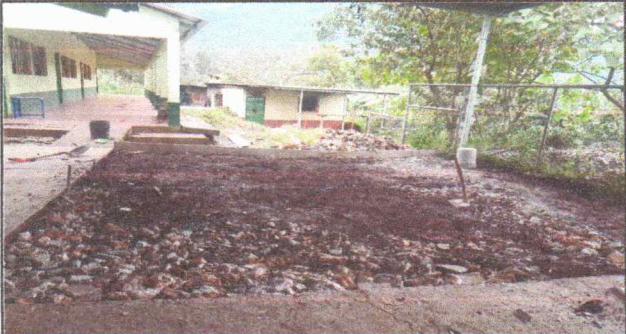
Foto1: sustitución de piso de torta de concreto
