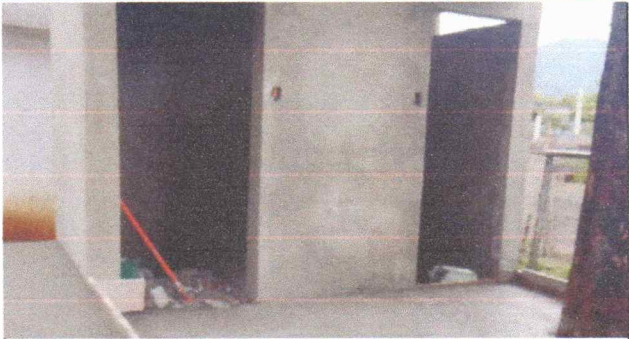
Foto 7: sustitución de puerta
