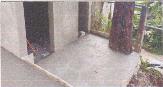
Foto 9: sustitución de piso de torta por piso de granito
