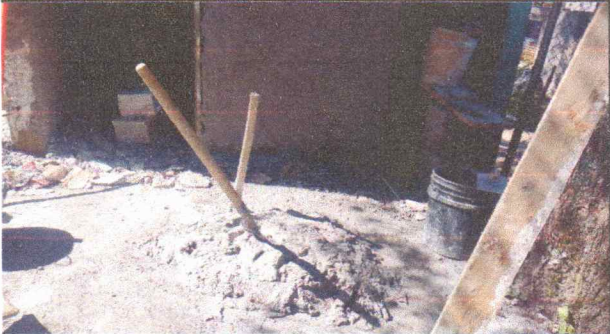
Foto 2: sustitución de piso de torta de concreto
