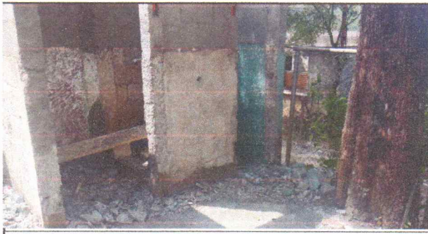
Foto 6: Sustitución de puertas de metal
