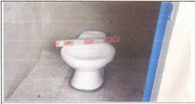
Foto 5: Sustitución de inodoros
