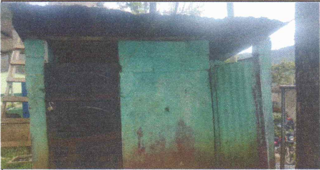
Foto 3: sustitución de lámina por lámina troquelada
