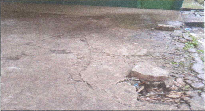
Foto1: sustitución de piso de torta de concreto
