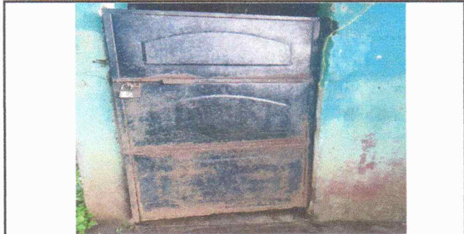
Foto 6: Sustitución de puertas de metal
