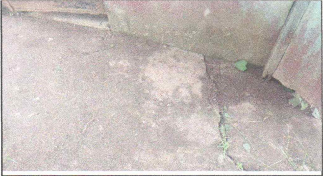
Foto 2: sustitución de piso de torta de concreto
