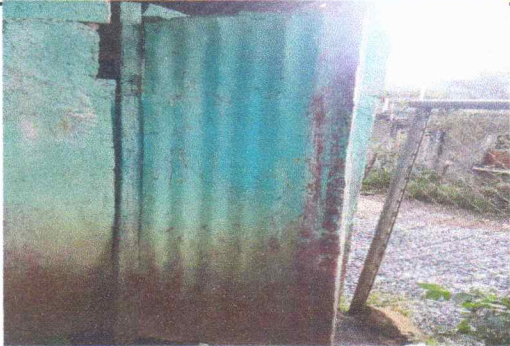
Foto 7: sustitución de puerta
