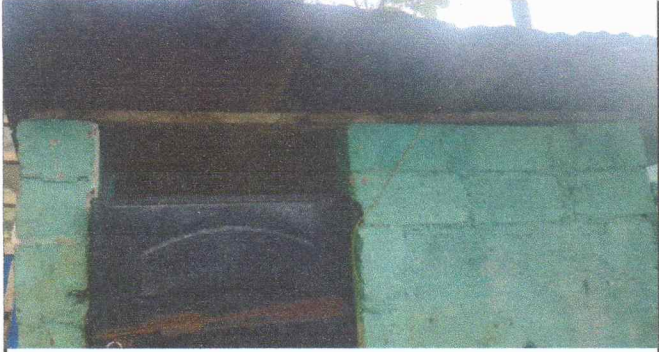
Foto 4: sustitución de estructura de soporte madera por soporte de metal
