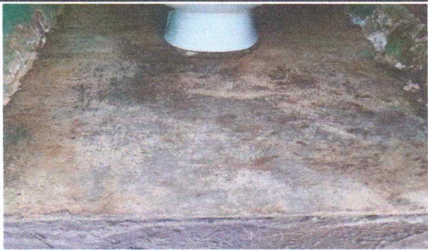
Foto 9: sustitución de piso de torta por piso de granito
