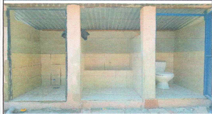
Foto 15: Sustitución de azulejos en servicios sanitarios
