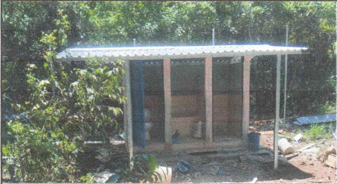
Foto 1: Techo de lámina sustituida
