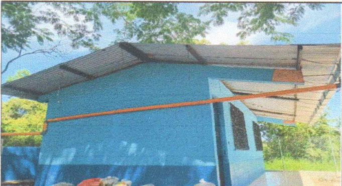
Foto 8: Bajada de agua pluvial en buenas condiciones
