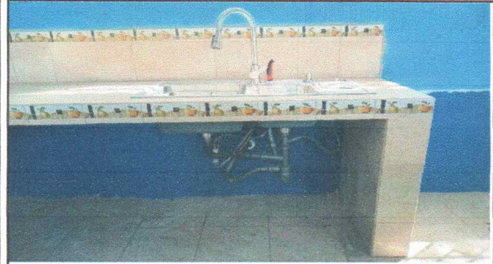
Foto 13: Sustitución de lavamanos
