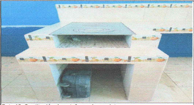
Foto 12: Sustitución de estufa rural completa
