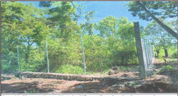
Foto 11: Muro perimetral de tubo HG y malla galvanizada reparada
