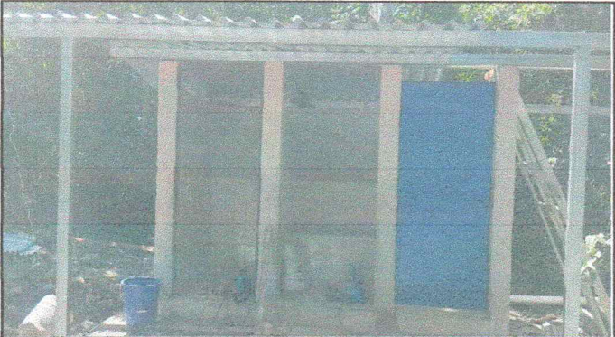
Foto 2: Soporte de madera en buenas condiciones
