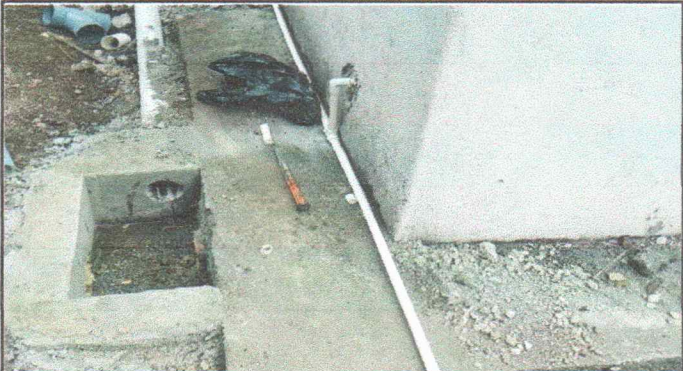
Foto 9: Sustitución de tubería de drenaje principal
