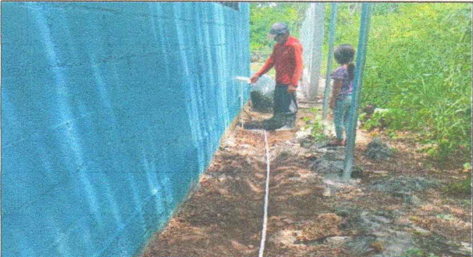
Foto 10: Sustitución de tubería de PVC línea principal
