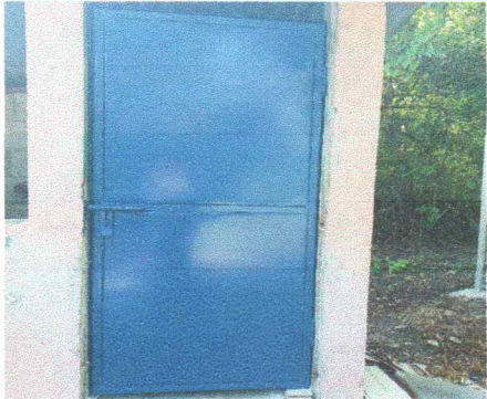
Foto 4: Puerta de metal instalada
