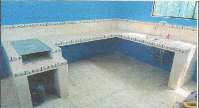
Foto 14: Sustitución de azulejos en muebles de cocina
