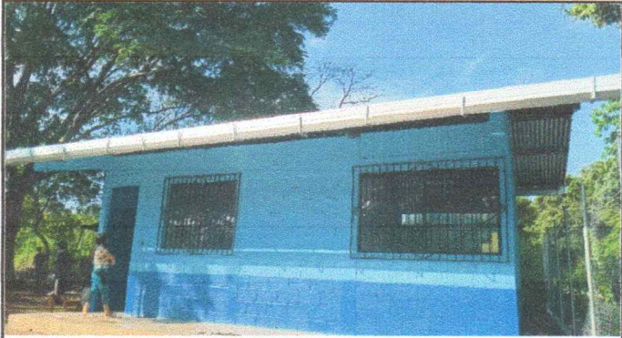
Foto 7: Canal de metal sustituida
